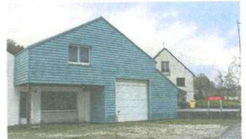
Le bâtiment qui abritera la future boucherie-charcuterie.
