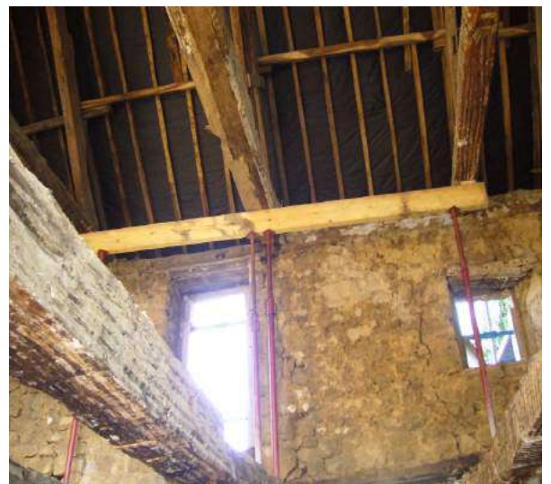
Impressionnants, les échafaudages
